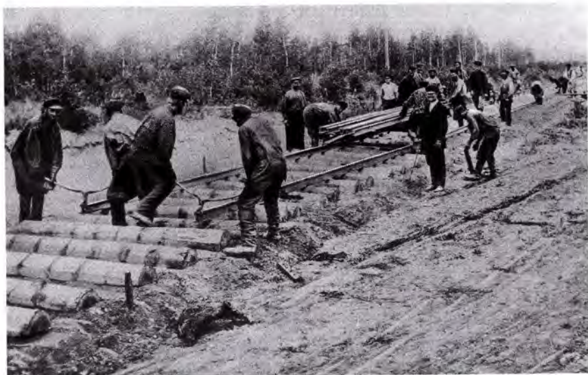
Строительство железной дороги во второй половине XIX в.
